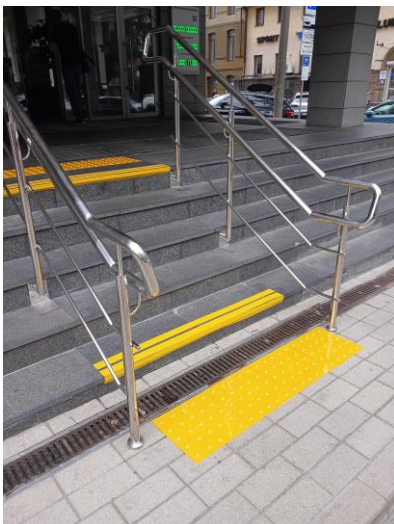
4.5. Приклад вкладання тактильної плитки і нековзкої стрічки на сходах:
