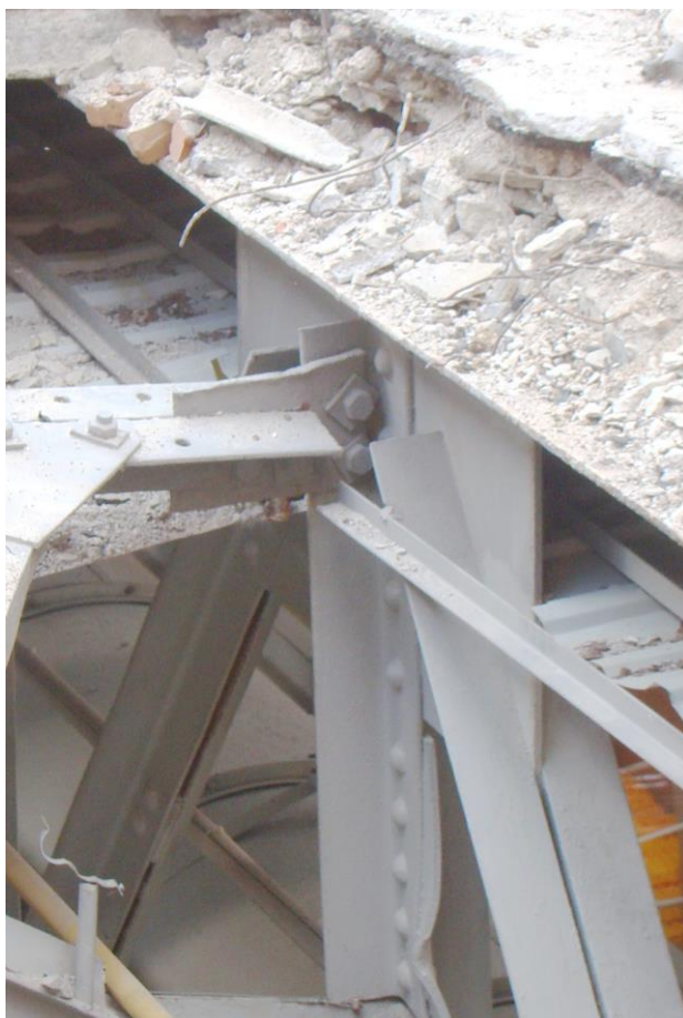
Мал. П.2.21. Вид на вузли примикання верхніх поясів кроквяних ферм покриття (в осях 1-5 та рядах Г-Д) – до підкроквяних ферм
