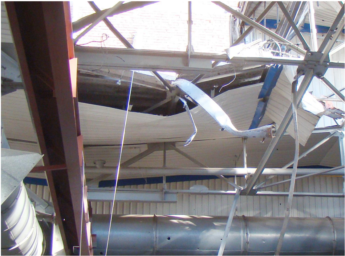
Мал. П.2.43. Руйнування розкосів зв'язків по нижніх поясах кроквяних ферм в рядах Г-Д та осях 1-2
