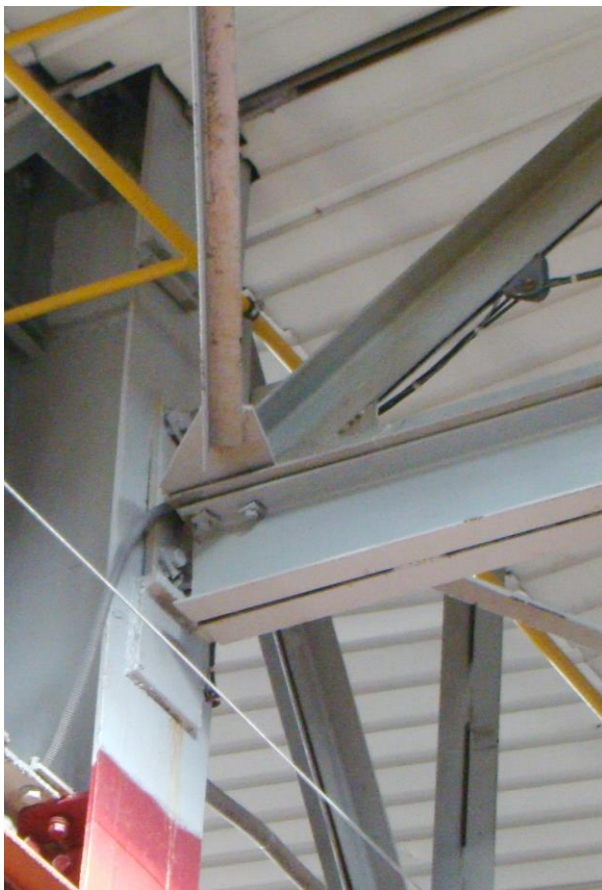
Мал. П.2.20. Вид на вузли примикання нижніх поясів кроквяних ферм покриття (в осях 1-5 та рядах Г-Д) – до підкроквяних ферм та колон
