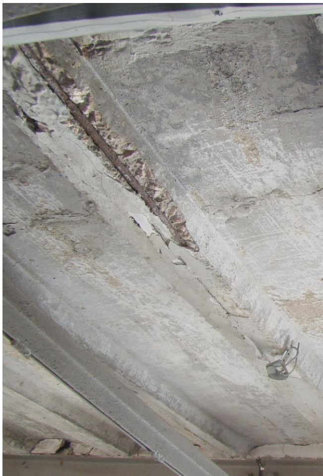
Мал. П.2.49. Відшарування захисного шару бетону ребер плит покриття (в осях 1-5 та рядах В-Г-Д), оголення стрижнів арматури плит
