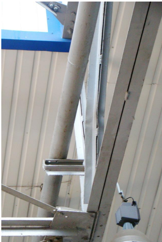
Мал. П.2.33. Вигини (зі стрілками 20÷25мм на довжині елемента – в площині та із площини ферм) елементів кроквяних ферм в рядах В-Г та осях 1-5
