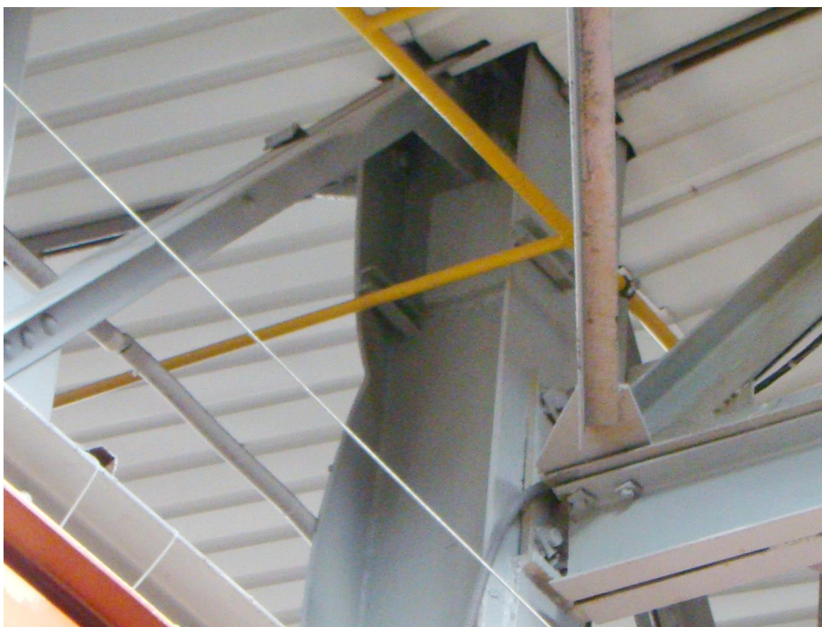
Мал. П.2.30. Місцева погнутість (зі стрілкою 70-80мм на довжині 400мм – в сторону ряду Д) полки зварного двотавру колони ряду Г по осі 3 (на відм. +6.800)
