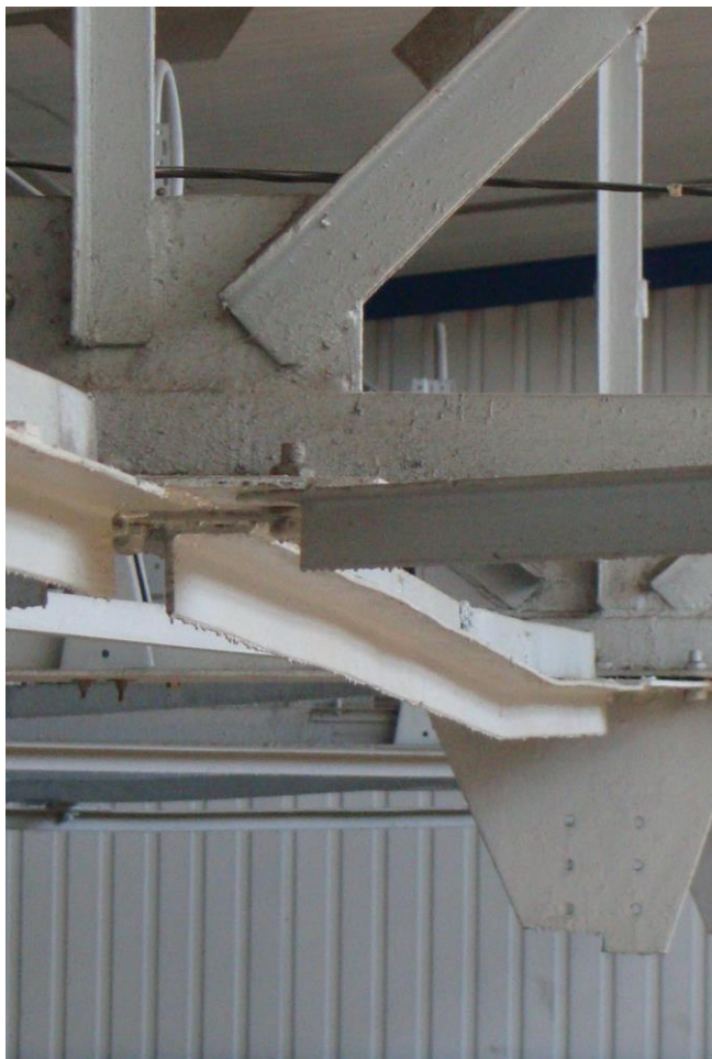
Мал. П.2.44. Вигини (зі стрілками 30÷40мм на довжині елемента – в площині та із площини елементів) елементів зв'язків покриття в рядах В-Г-Д та осях 1-5
