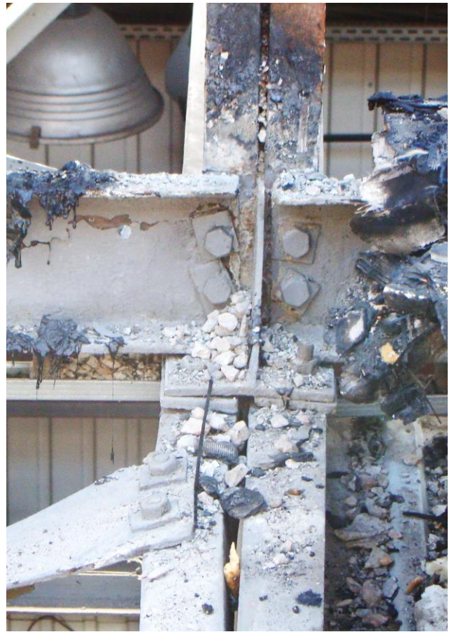
Мал. П.2.25. Вид на вузли обпирання прогонів (в осях 1-5 та рядах Г-Д) - на верхні пояси кроквяних ферм покриття прольоту Г-Д
