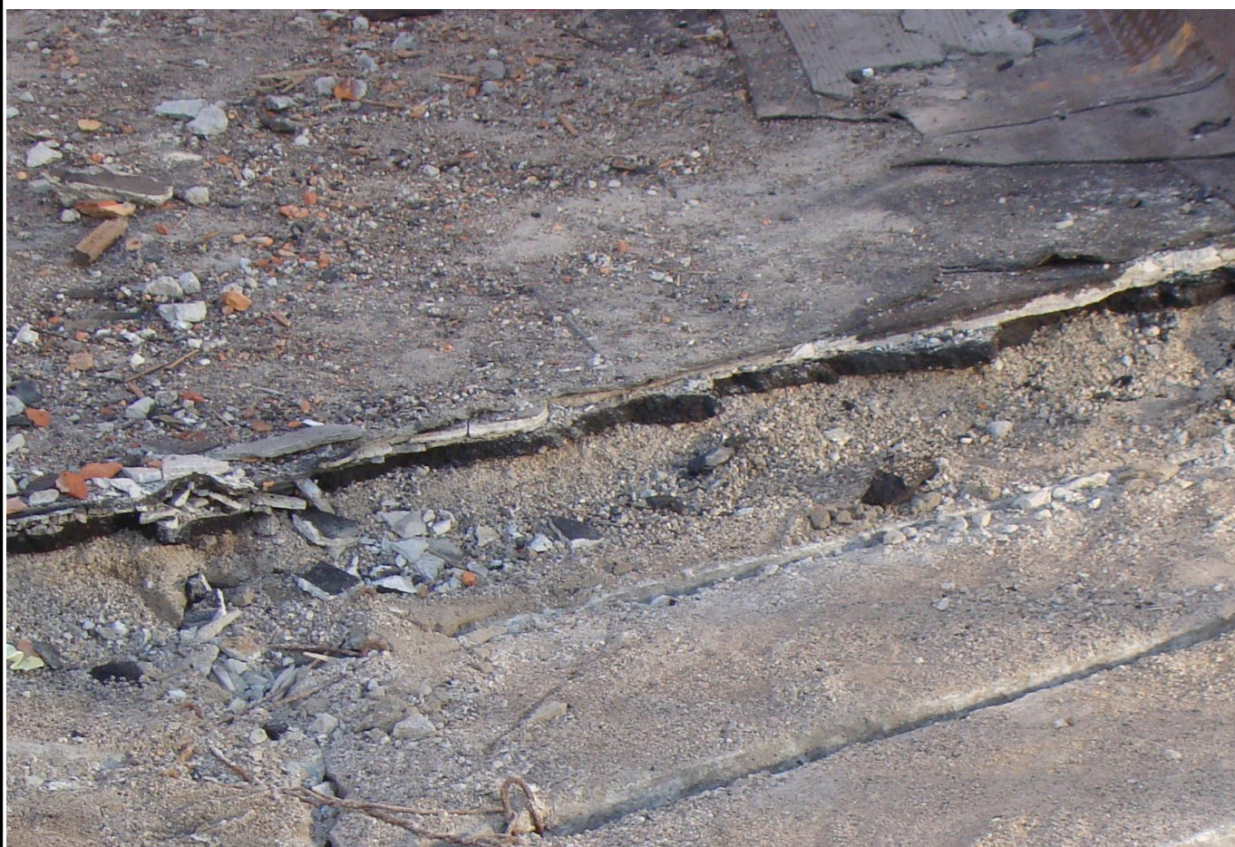
Мал. П.2.9. Вид на склад покрівлі – в осях 1-5 та рядах В-Г-Д
