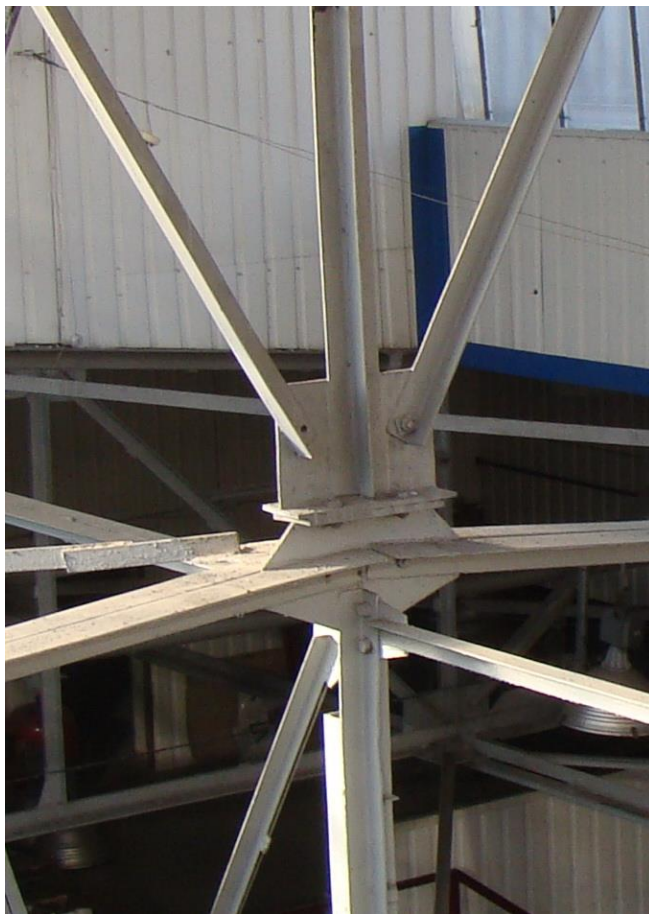
Мал. П.2.6. Вид на вузли примикання ферми ліхтаря до верхнього поясу кроквяної ферм покриття - в осях 1-5 та рядах В-Г
