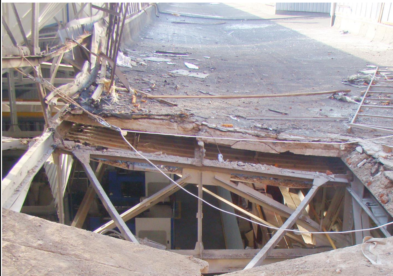
Мал. П.2.24. Вид на конструкції прогонів – в осях 1-5 та рядах Г-Д
