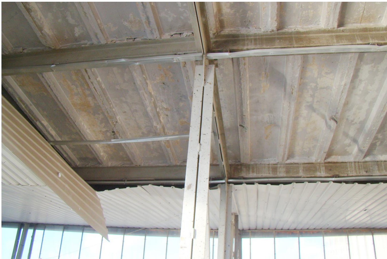
Мал. П.2.8. Вид на конструкції прогонів та плит покриття (на ліхтарі) – в осях 1-5 та рядах В-Г
