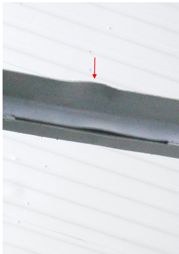
Мал. П.2.36. Малкування та розмалкування (зі стрілками до 30мм на довжині до 150мм) полук кутиків елементів кроквяних ферм в рядах В-Г-Д та осях 1-5
