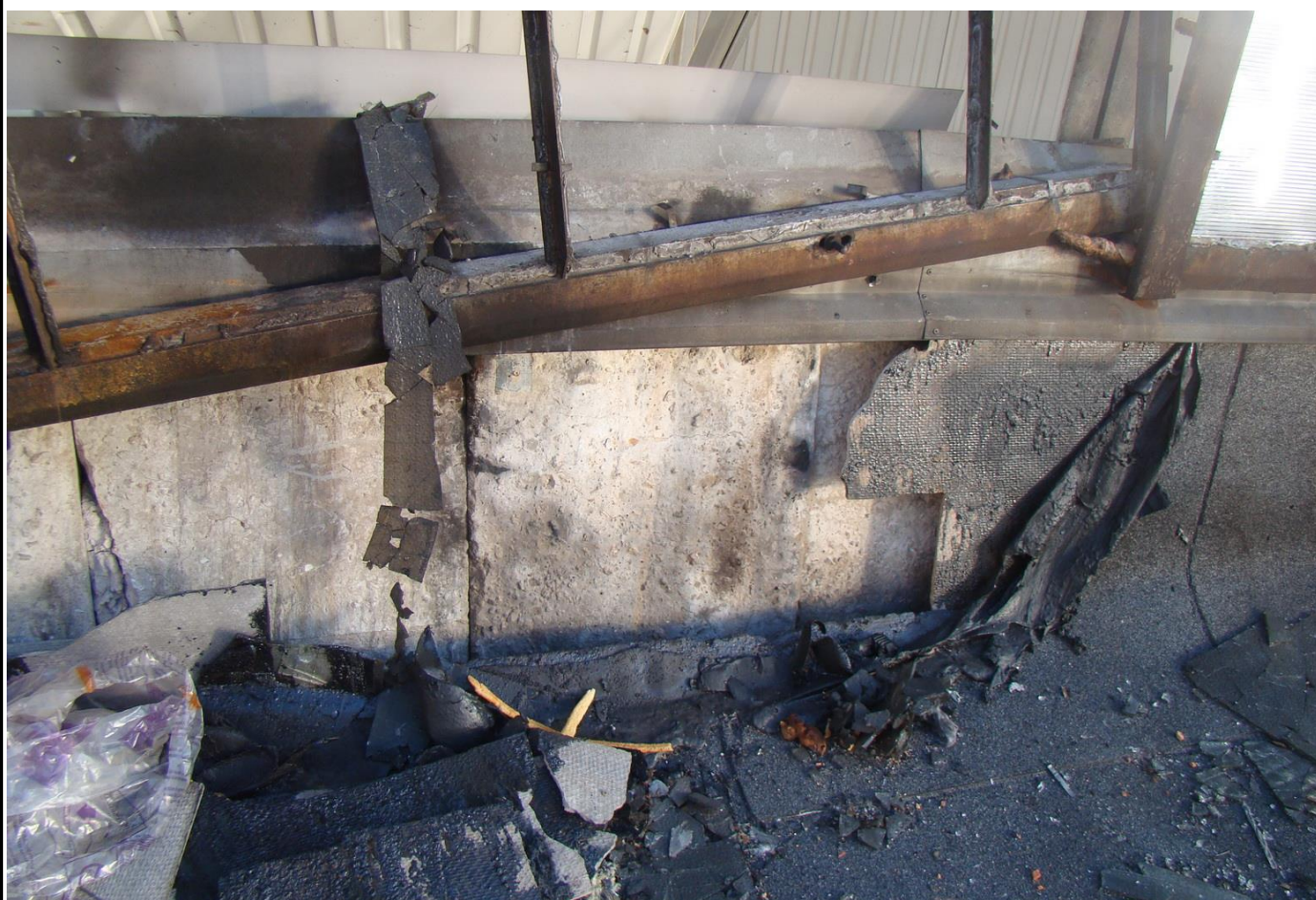
Мал. П.2.28. Вид на плити бокового огородження ліхтарів (в осях 1-5 та рядах В-Г та Г-Д)
