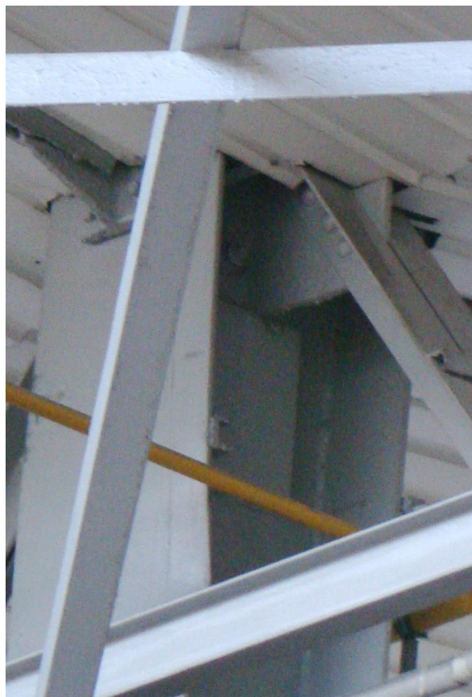
Мал. П.2.18. Вид на вузли примикання верхніх та нижніх поясів підкроквяних ферм (по ряду Г в осях 1-5) – до колон ряду Г
