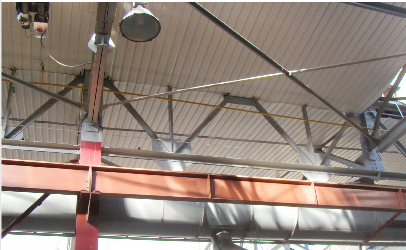
Мал. П.2.17. Вид на конструкції підкроквяних ферм – по ряду Г в осях 1-5
