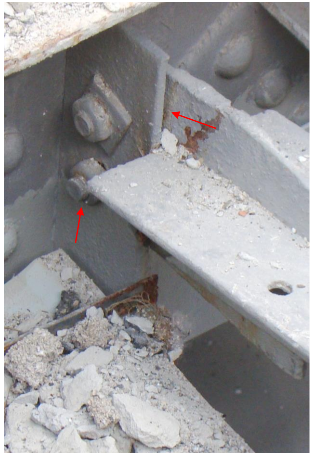
Мал. П.2.41. Погнутість вузлової фасонки верхнього поясу кроквяної ферми в рядах Г-Д по осі 2 – в місці кріплення до колони ряду Г, ослаблення болтів кріплення вузлової фасонки до підкроквяної ферми
