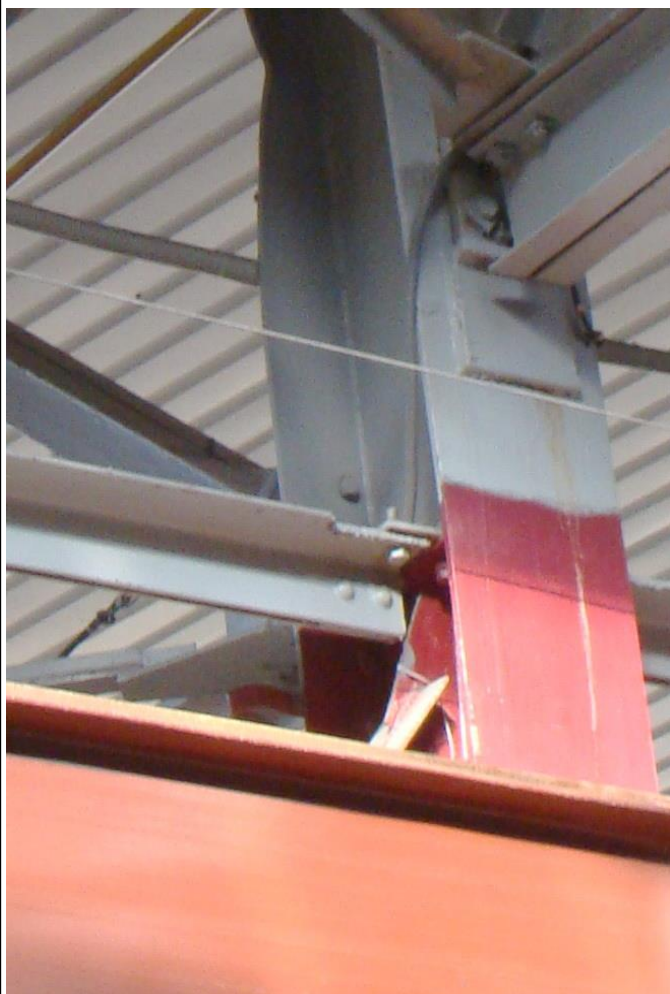
Мал. П.2.18. Вид на вузли примикання верхніх та нижніх поясів підкроквяних ферм (по ряду Г в осях 1-5) – до колон ряду Г
