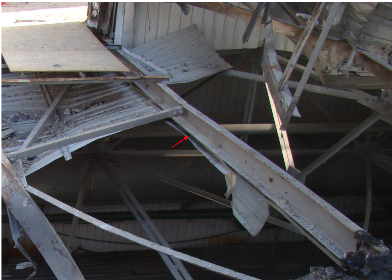
Мал. П.2.47. Вигин (зі стрілкою 40мм – із площини елемента) прогону покрівлі (по верхнім поясам кроквяних ферм) в рядах Г-Д та осях 1-2
