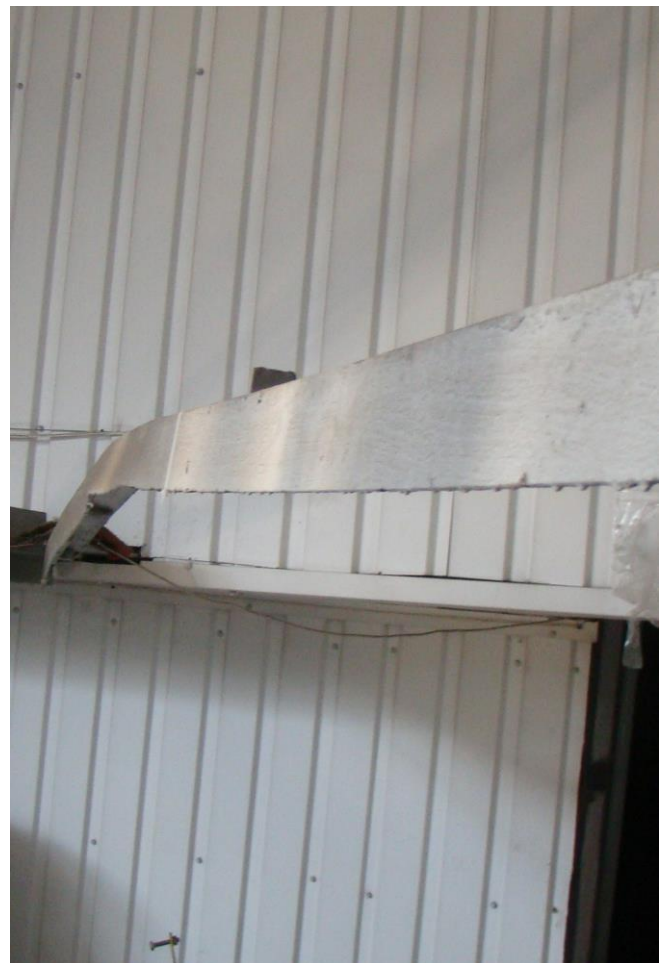
Мал. П.2.44. Вигини (зі стрілками 30÷40мм на довжині елемента – в площині та із площини елементів) елементів зв'язків покриття в рядах В-Г-Д та осях 1-5
