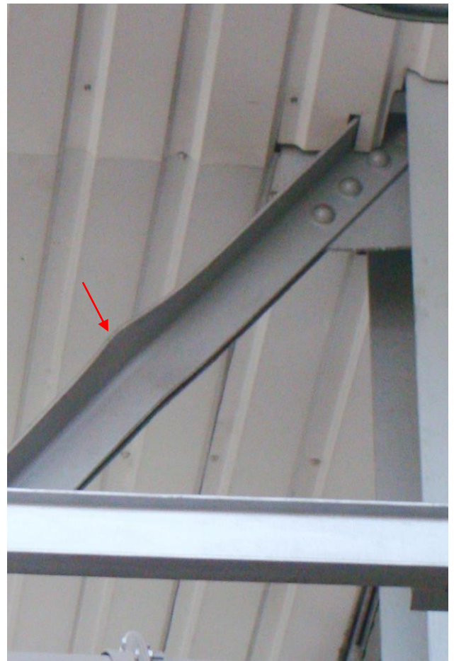
Мал. П.2.32. Малкування та розмалкування (зі стрілками до 20мм на довжині до 200мм) полук кутиків елементів підкроквяних ферм по ряду Г в осях 1-5
