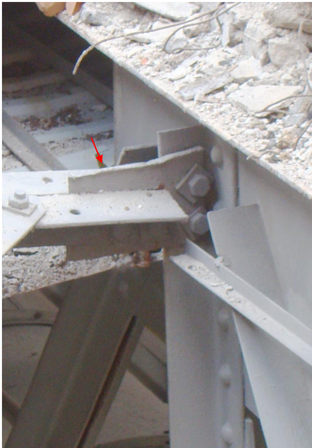
Мал. П.2.41. Погнутість вузлової фасонки верхнього поясу кроквяної ферми в рядах Г-Д по осі 2 – в місці кріплення до колони ряду Г, ослаблення болтів кріплення вузлової фасонки до підкроквяної ферми
