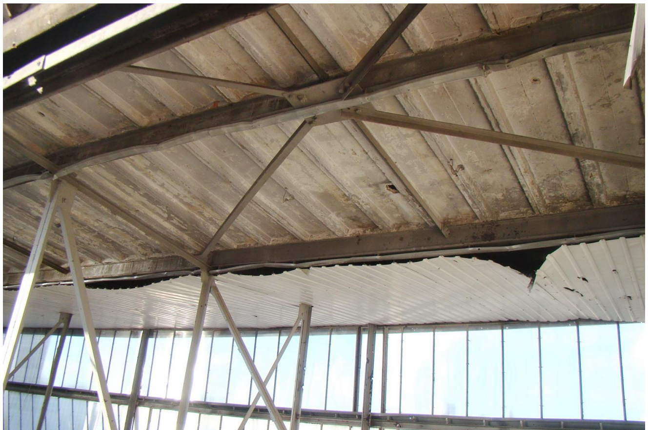
Мал. П.2.7. Вид на конструкції зв'язків по верхнім поясам ферм ліхтаря – в осях 1-5 та рядах В-Г
