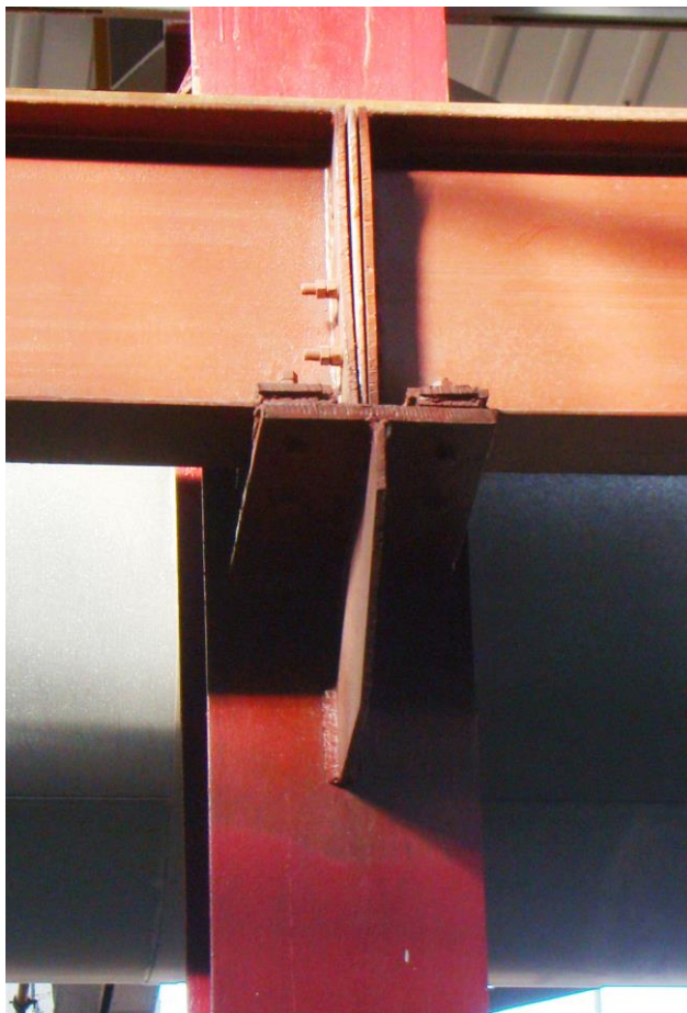
Мал. П.2.15. Вид на вузли обпирання підкранових балок (в осях 1-5 та рядах Г-Д) – на колони рядів Г-Д
