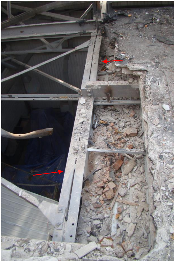
Мал. П.2.39. Вигини (зі стрілками 20÷30мм на довжині елемента – в сторону осі 1 та осі 3) верхнього поясу кроквяної ферми в рядах Г-Д по осі 2
