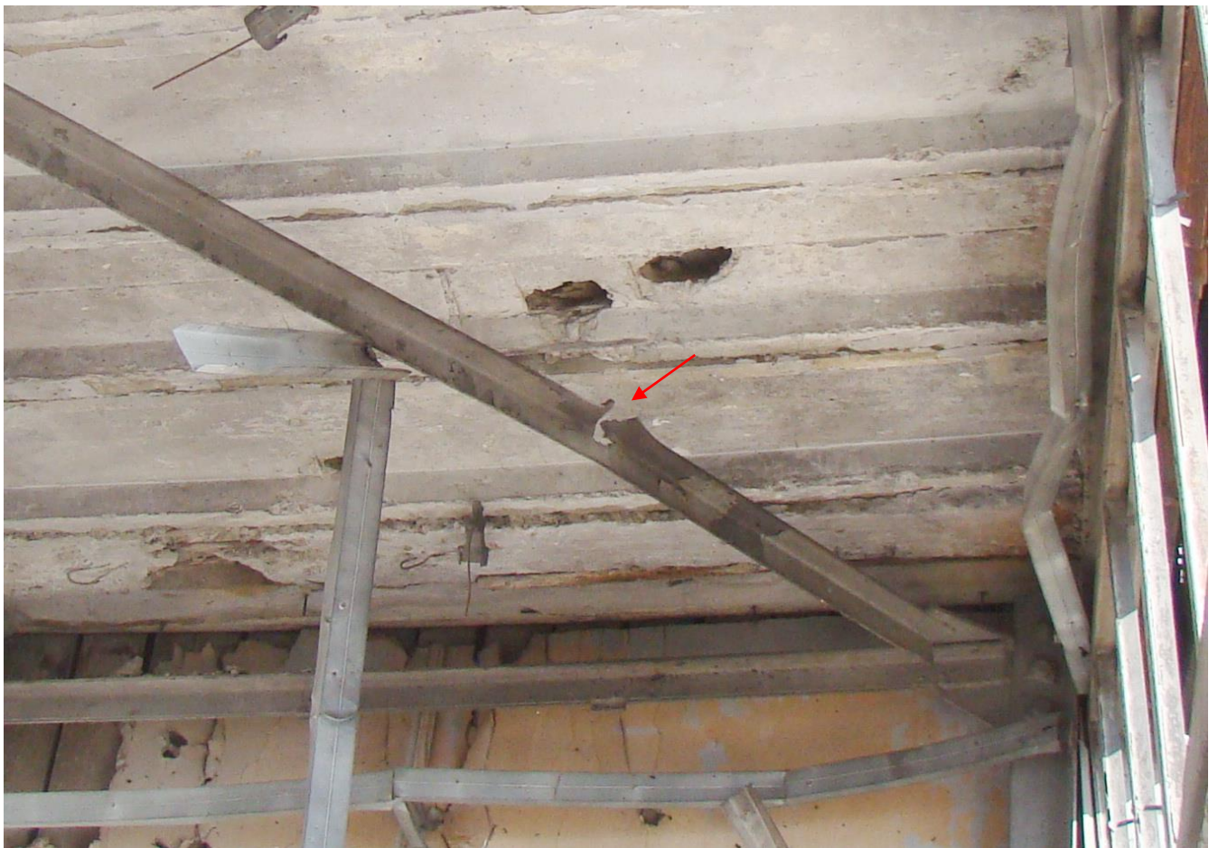
Мал. П.2.45. Ви́рив (із розмірами 60х60мм) в полці кутика зв'язків по верхнім поясам ферм ліхтаря в рядах В-Г та осях 1-2
