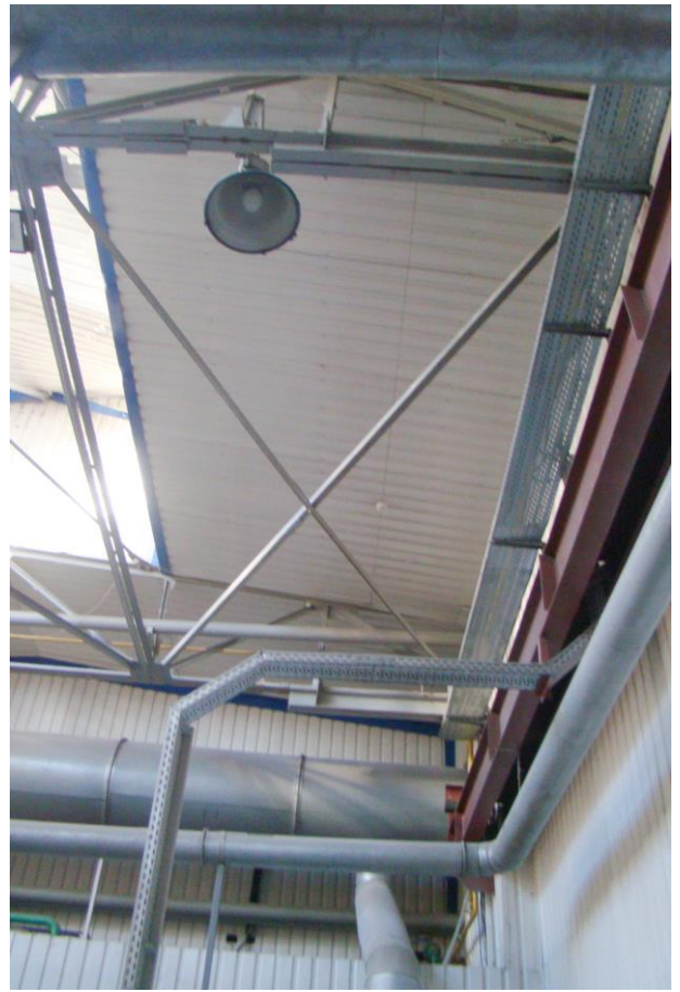
Мал. П.2.22. Вид на конструкції зв'язків по нижніх поясах кроквяних ферм покриття – в осях 1-5 та рядах Г-Д
