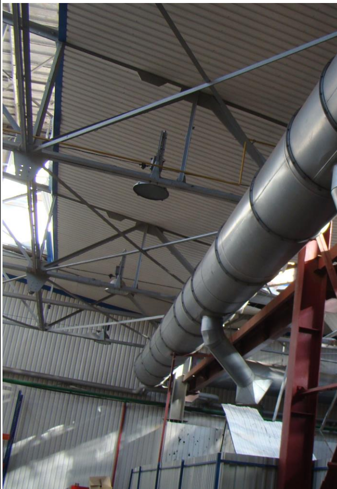
Мал. П.2.3. Вид на конструкції зв'язків по нижніх поясах кроквяних ферм покриття – в осях 1-5 та рядах В-Г
