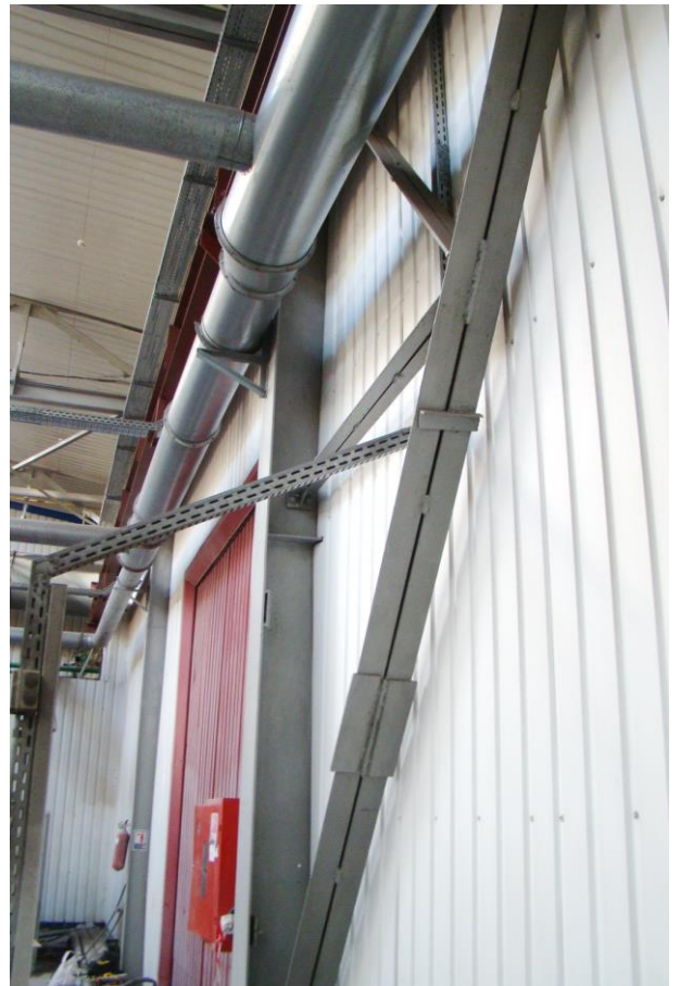
Мал. П.2.12. Вид на конструкції вертикальних зв'язків – по колонах рядів Г і Д в осях 3-5
