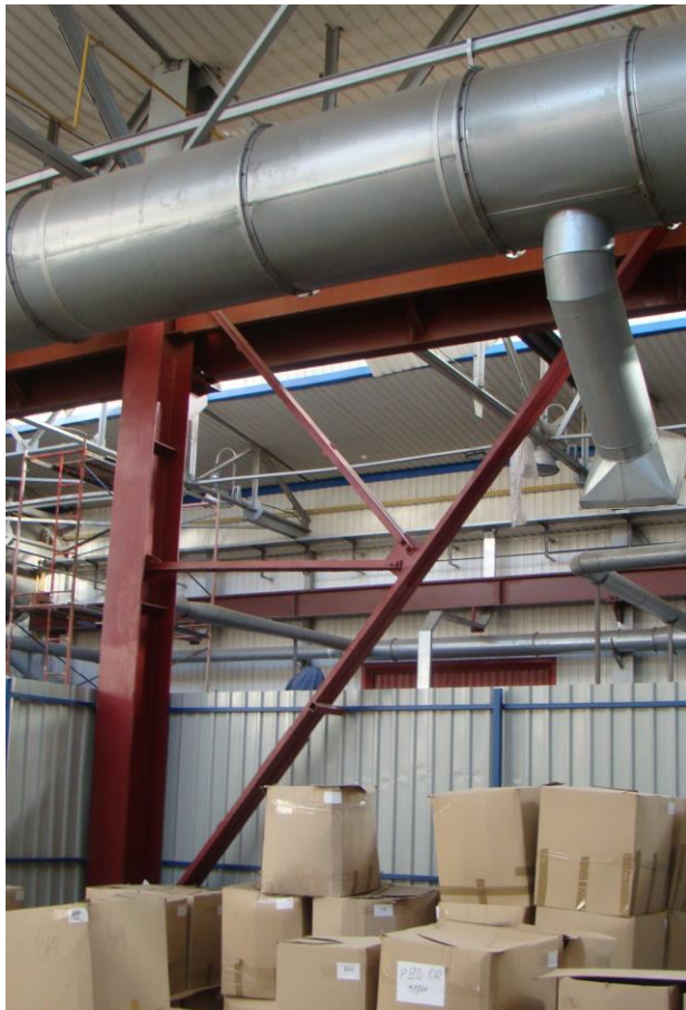
Мал. П.2.12. Вид на конструкції вертикальних зв'язків – по колонах рядів Г і Д в осях 3-5
