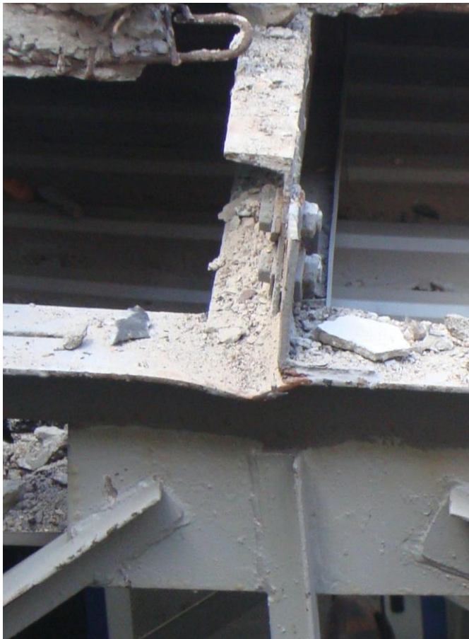
Мал. П.2.25. Вид на вузли обпирання прогонів (в осях 1-5 та рядах Г-Д) - на верхні пояси кроквяних ферм покриття прольоту Г-Д
