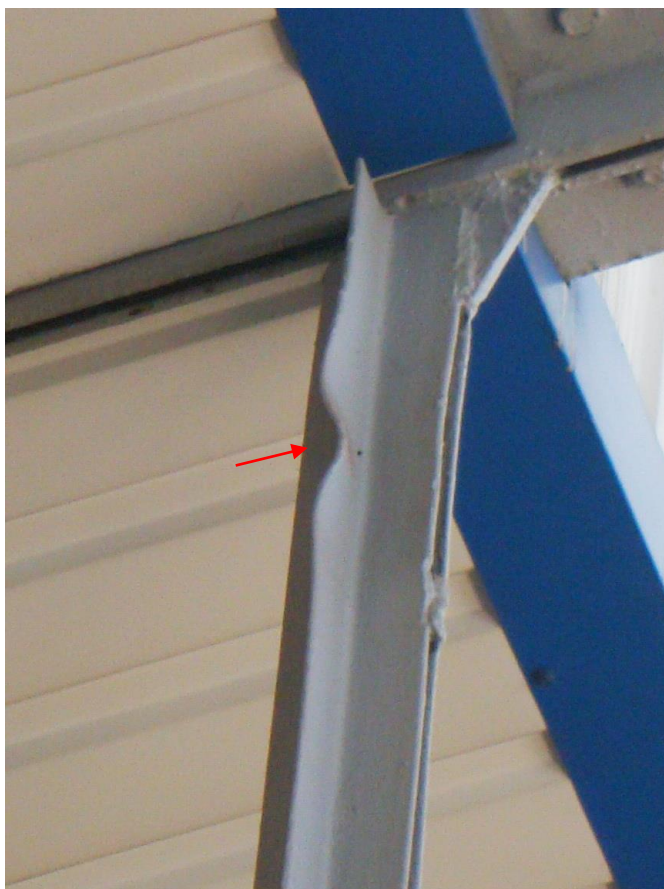
Мал. П.2.36. Малкування та розмалкування (зі стрілками до 30мм на довжині до 150мм) полук кутиків елементів кроквяних ферм в рядах В-Г-Д та осях 1-5
