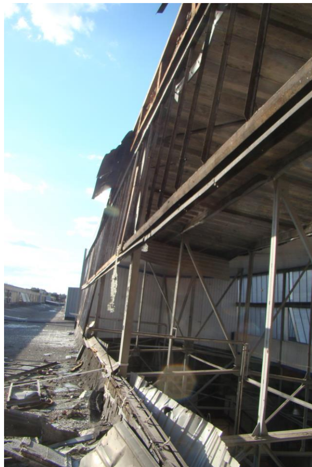
Мал. П.2.51. Руйнування віконних рам ліхтарів (в осях 1-5 та рядах В-Г-Д)
