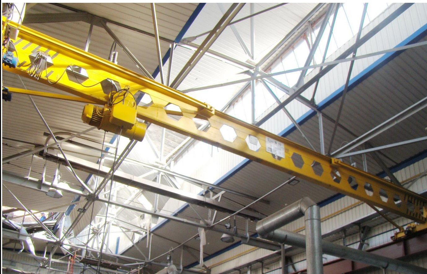
Мал. П.2.19. Вид на кроквяні ферми покриття – в осях 1-5 та рядах Г-Д
