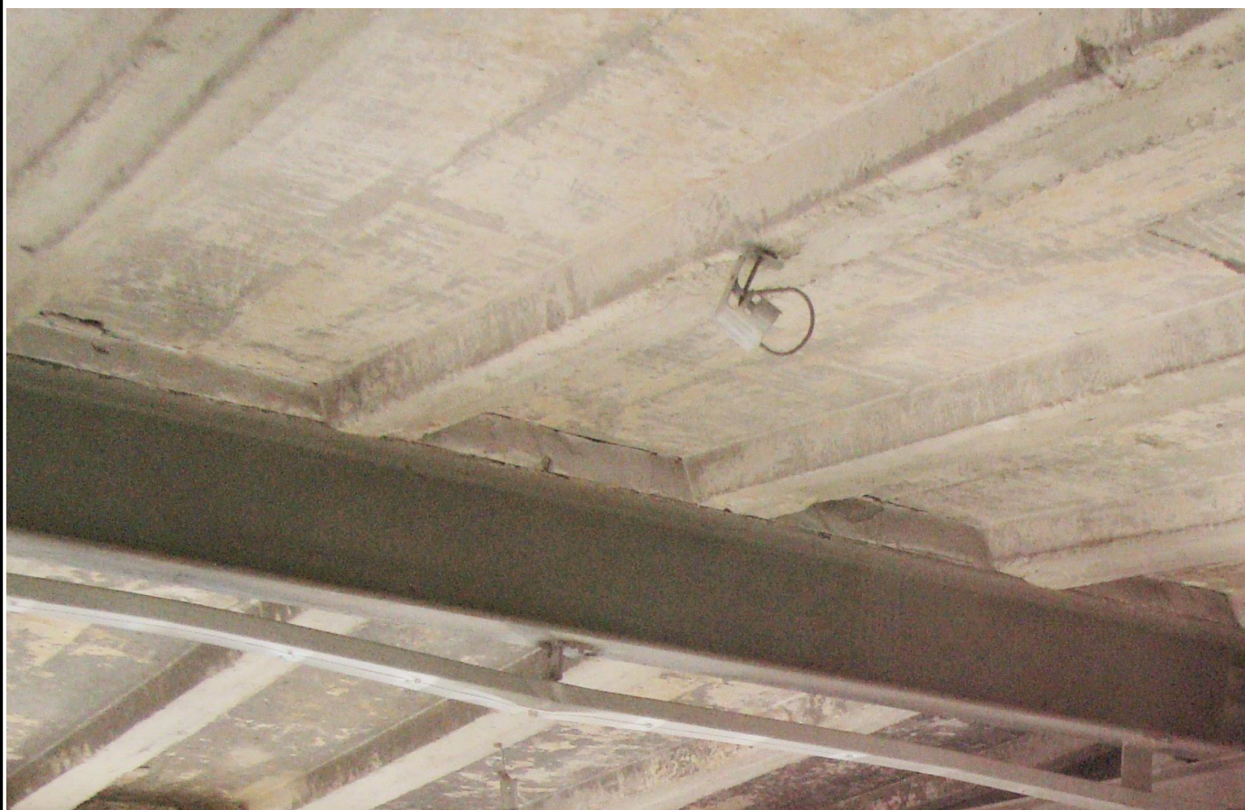
Мал. П.2.27. Вид на вузли обпирання плит покриття на прогони
