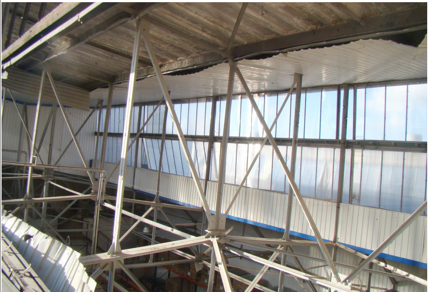
Мал. П.2.5. Вид на конструкції ферми ліхтаря – в осях 1-5 та рядах В-Г
