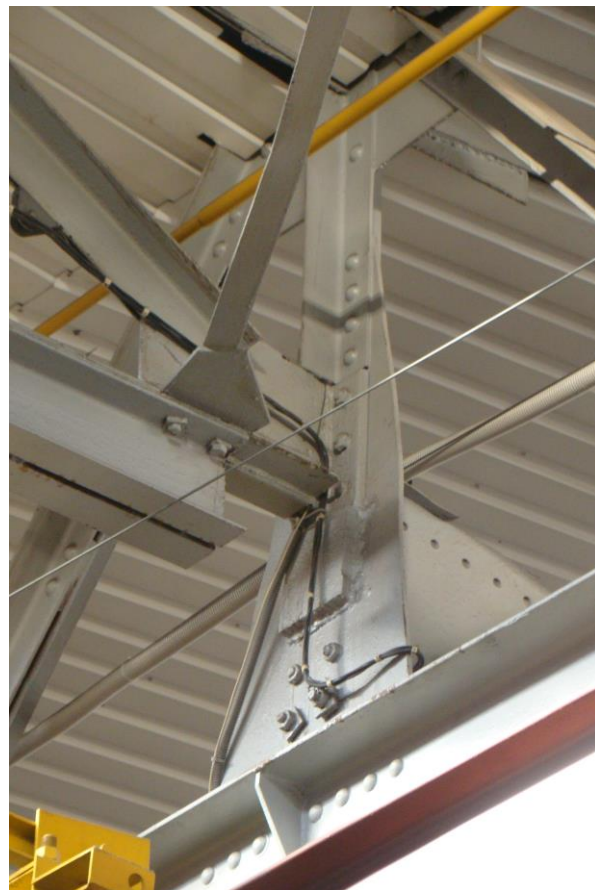
Мал. П.2.20. Вид на вузли примикання нижніх поясів кроквяних ферм покриття (в осях 1-5 та рядах Г-Д) – до підкроквяних ферм та колон
