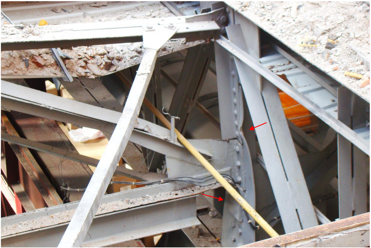
Мал. П.2.31. Вигин (зі стрілкою 40мм на довжині елемента – в сторону ряду В) середньої стійки підкроквяної ферми по ряду Г в осях 1-3, місцевий вигин (зі стрілкою 60мм на довжині 450мм) листа стійки
