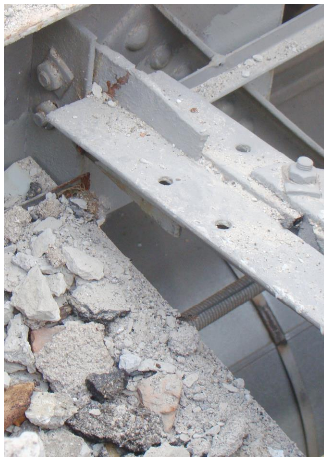
Мал. П.2.21. Вид на вузли примикання верхніх поясів кроквяних ферм покриття (в осях 1-5 та рядах Г-Д) – до підкроквяних ферм
