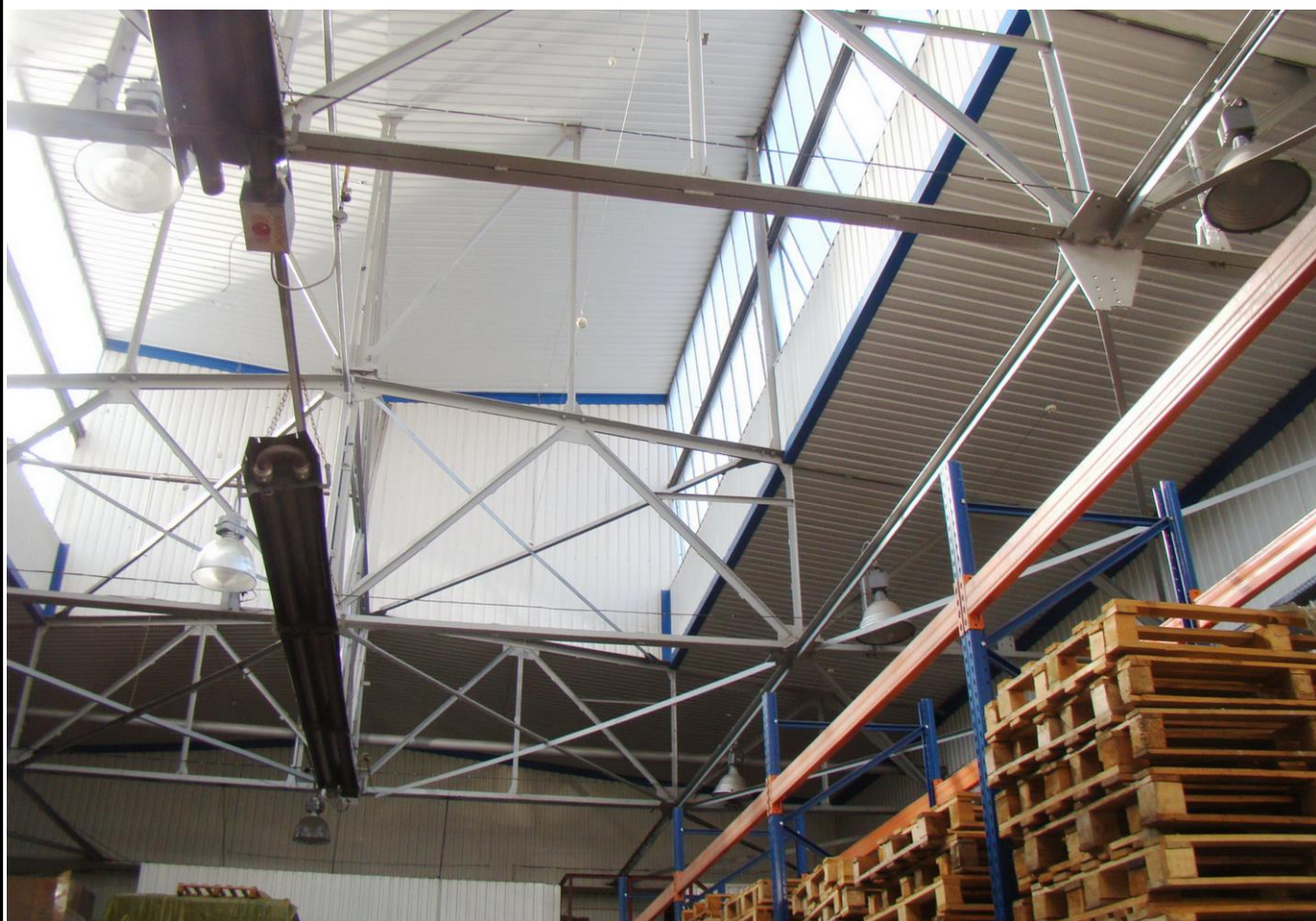
Мал. П.2.2. Вид на кроквяні ферми покриття – в осях 1-5 та рядах В-Г
