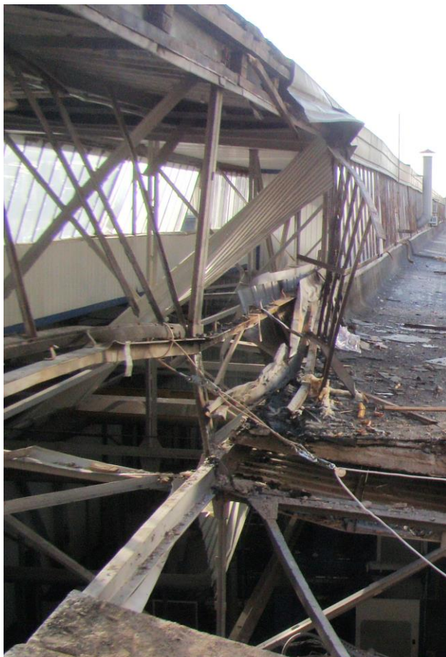
Мал. П.2.51. Руйнування віконних рам ліхтарів (в осях 1-5 та рядах В-Г-Д)
