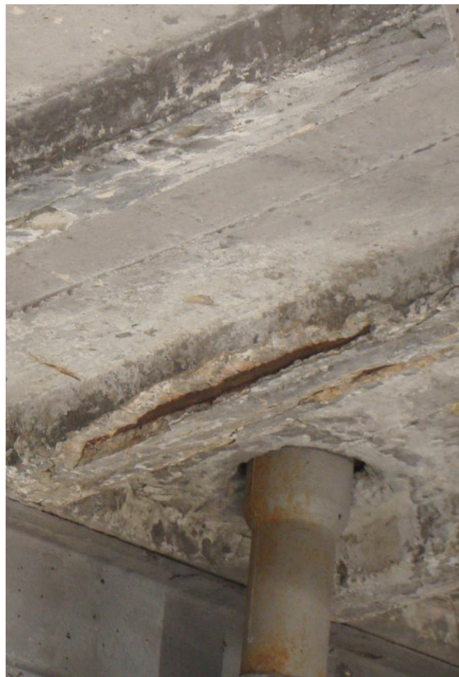
Мал. П.2.49. Відшарування захисного шару бетону ребер плит покриття (в осях 1-5 та рядах В-Г-Д), оголення стрижнів арматури плит
